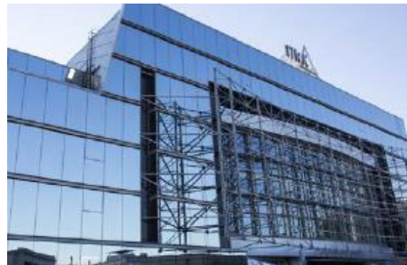
ТРК «ПИК» г. Санкт-Петербург
